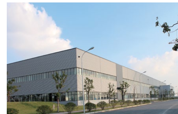
科研装配厂房实景5
