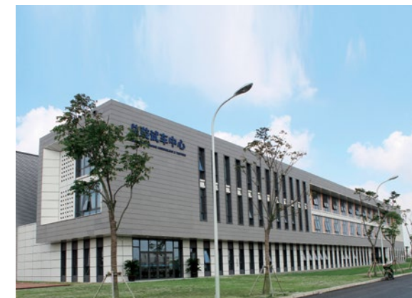
科研装配厂房实景4
