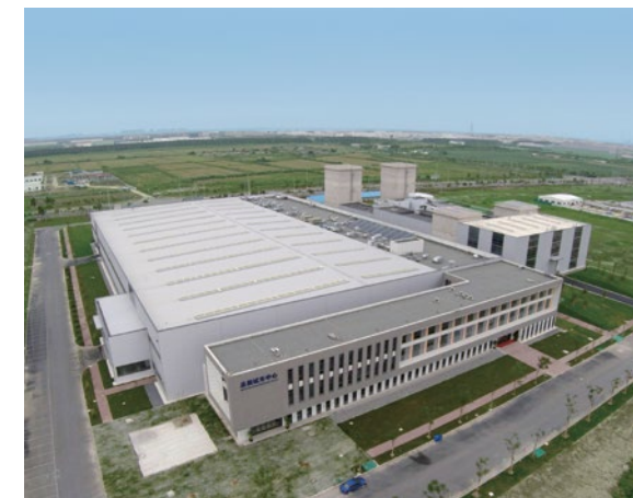
科研装配厂房实景2
