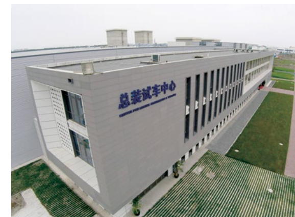
科研装配厂房实景3
