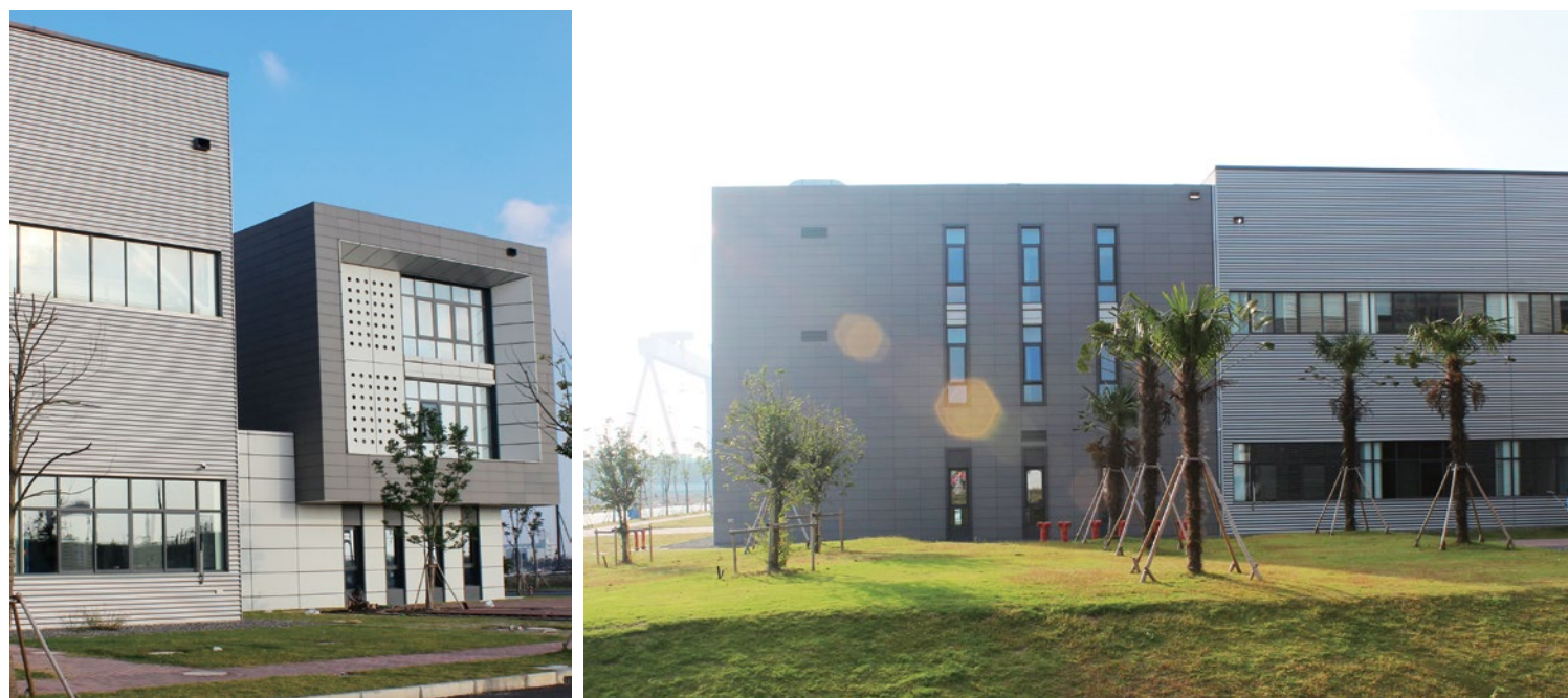
附楼与主厂房交接处外立面不同材质的模数制尺寸设计
