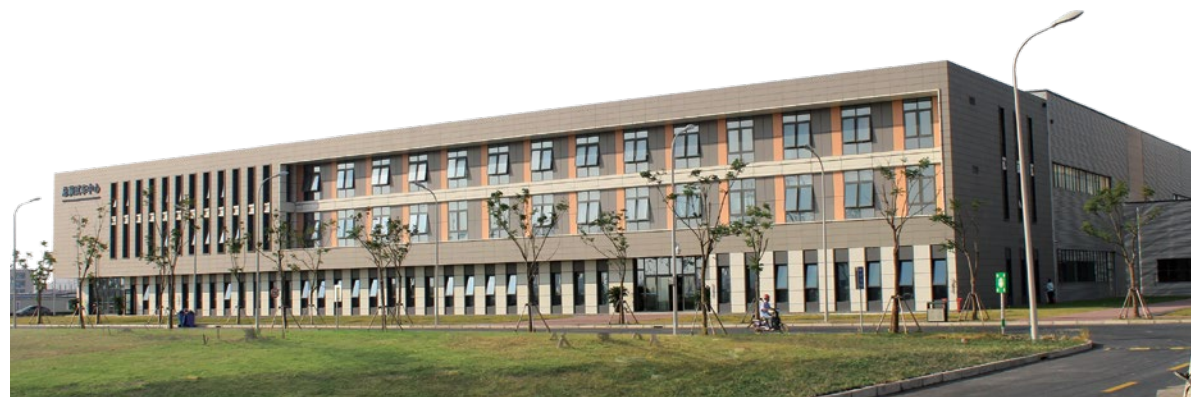
科研装配厂房实景1
