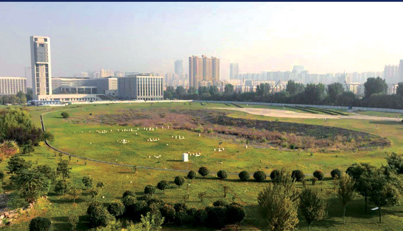
中国航空工业集团公司洛阳电光设备研究所洛南新区新建试制大楼（试验厂房）
